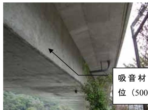
吸音材施工部位 (500m<sup>2</sup>)
